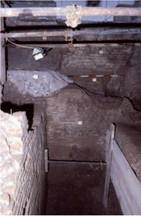
Fig. 12. Muratura in opus mixtum .
