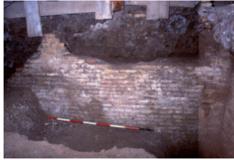
Fig. 13. Muratura in laterizio.
